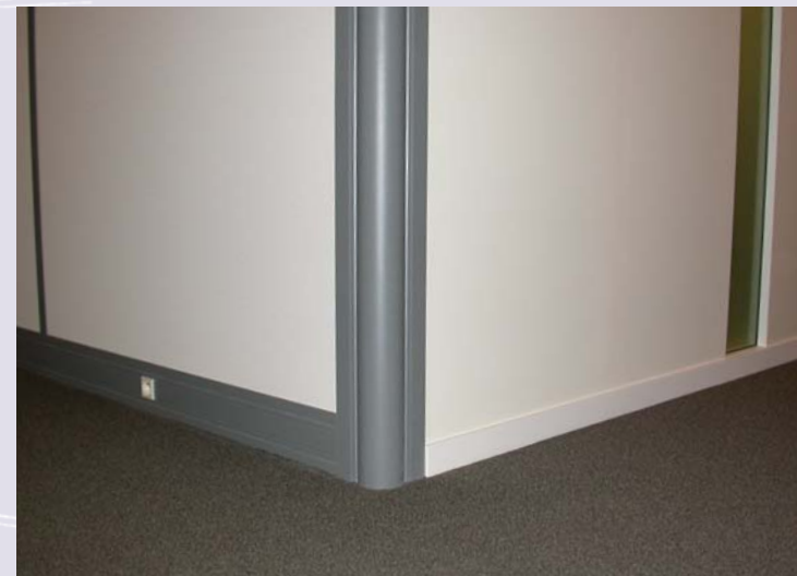
Vue d'un angle en liaison SPACE et SOGYPAC Corner between SPACE and SOGYPAC partition
