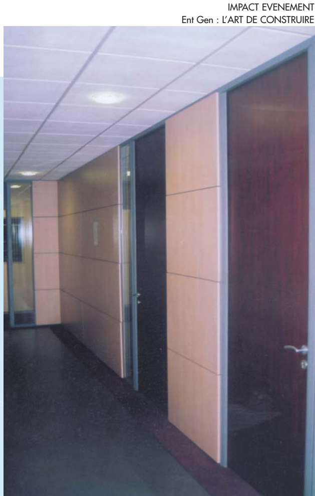
Joints avec jonc en surépaisseur Joint with thicker plastic filler rod
